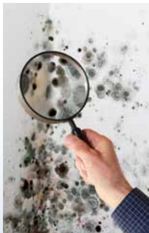
Schimmelbildung bei feuchter Raumluft
